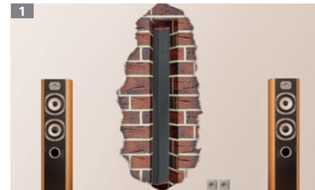
Multimedia-Rohr in der Wand montiert
